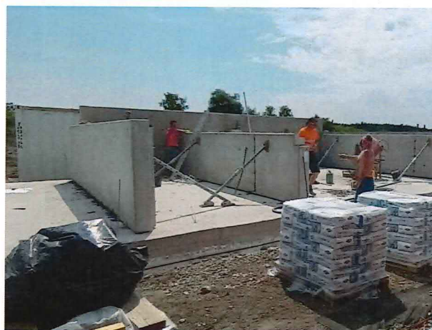
UČS 10, Montáž prefa, transformátorovňa
