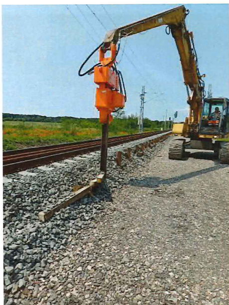
UČS 11, Rušenie záporového paženia HEB
