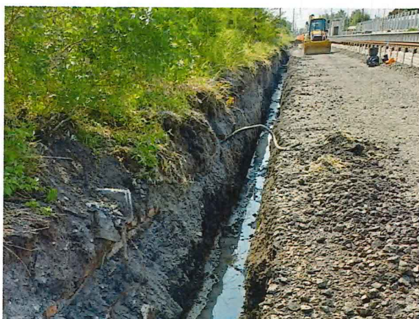
UČS 11, Realizácia drenážneho odvodnenia
