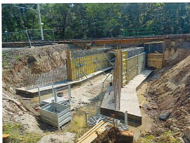
UČS 10, Armovanie, debnenie a betonáž stien priepustu
