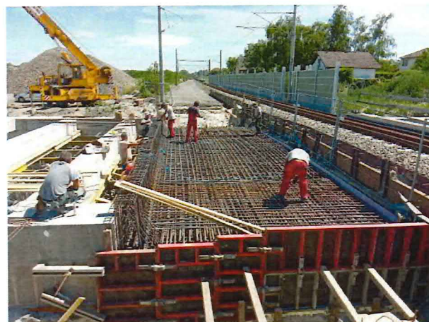
UČS 11, Armovanie mostovky, podjazd
