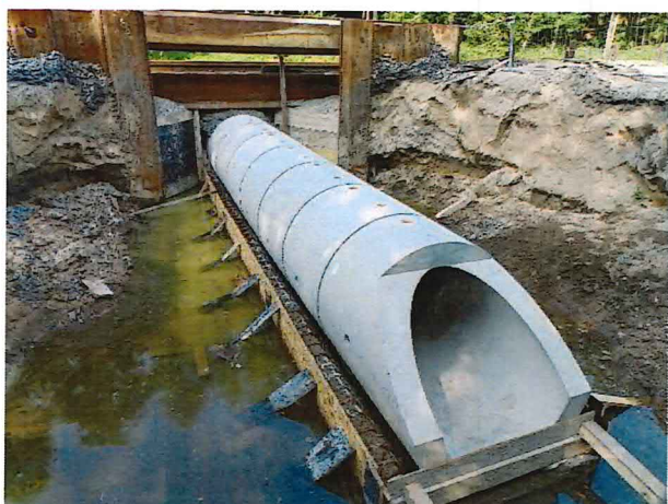
UČS 10, Osadenie žb rúr a obetónovanie, priepusty
