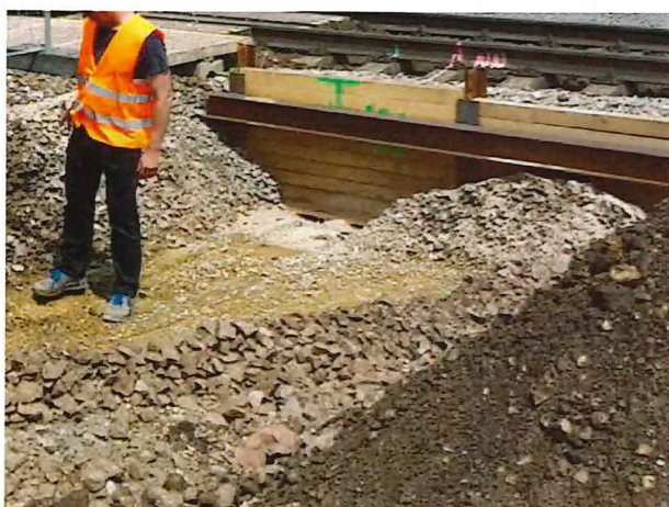
UČS 02, Realizácia kopanej sondy
