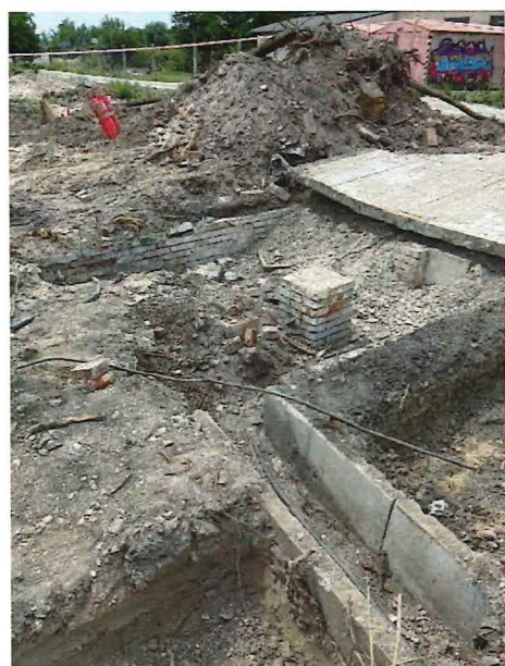
UČS 02, Vyberanie nefunkčných káblov, obnaženie funkčných trás, búranie betónov
