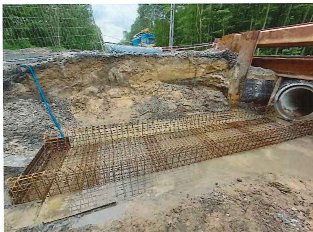
UČS 11, Rušenie záporového paženia HEB
