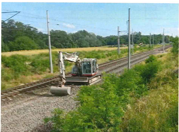
UČS 01, Odt'azenie starého koľajového kameňa
