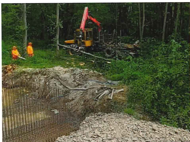
UČS 10, Výrub a zriadenie obchádzkovej trasy pri budovaní priepustu
