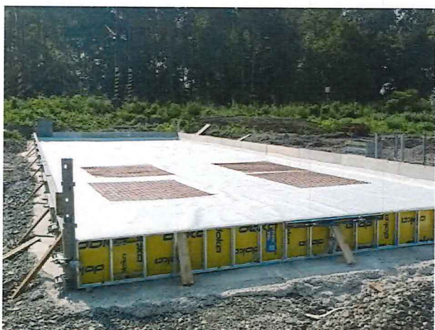
UČS 10, Armovanie základovej dosky, TNS Kúty stanovište transformátorov
