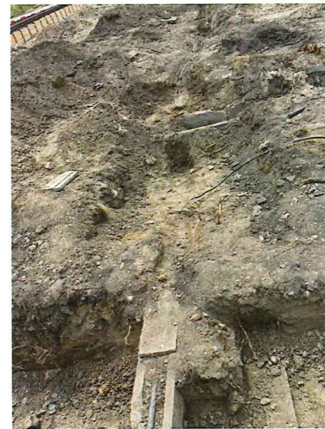
UČS 02, Vyberanie nefunkčných káblov, obnaženie funkčných trás, búranie betónov
