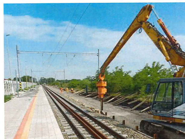
UČS 10, Rušenie záporového paženia
