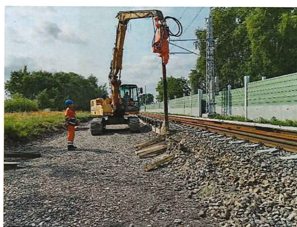
UČS 10, Rušenie záporového paženia HEB
