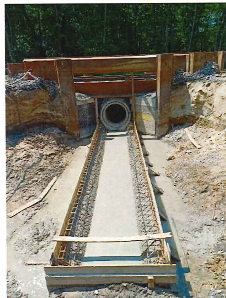
UČS 10, Armovanie, debnenie a betonáž základovej dosky pre priepust
