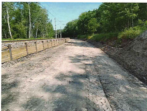
UČS 10, Odkop po zemnú pláň, vykonanie SZS
