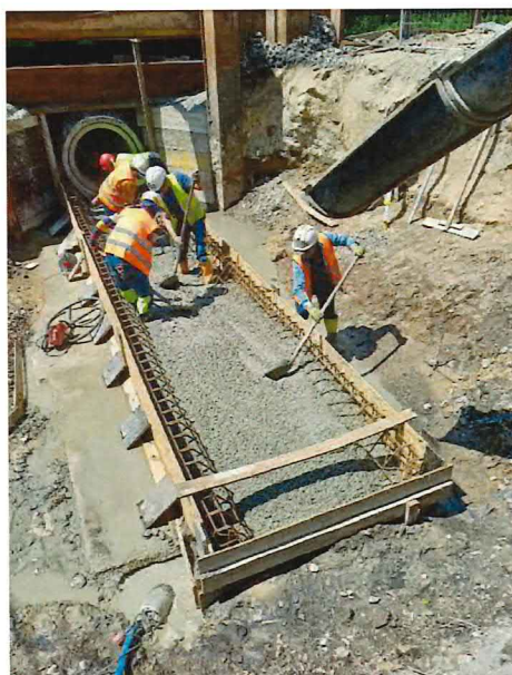
UČS 10, Armovanie, debnenie a betonáž základovej dosky pre priepust
