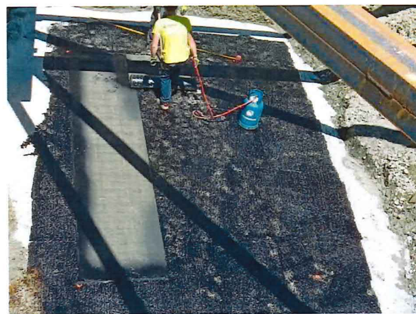
UČS 11, Realizácia podkladného betónu, a hydroizolácie
