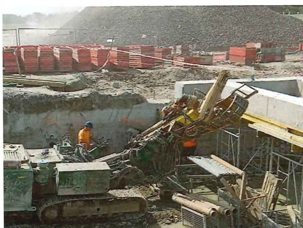
UČS 11, Kotvenie stien podjazd
