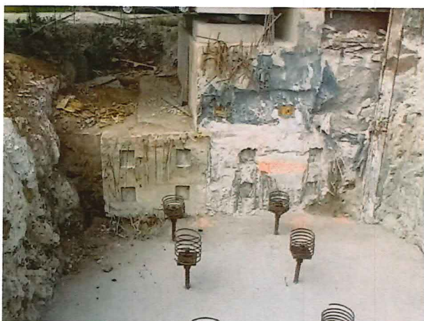
UČS 12, Realizácia podkladných betónov a šmyková výstuž
